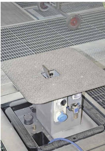
Energieampeln sind in den Kabinenboden versenkt worden, sodass die Beweglichkeit der Kabine nicht beeinträchtigt wird.
