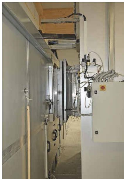
An jeder der fünf möglichen Positionen der Kabine kann über eine Dockingstation Zuluft entnommen werden.
